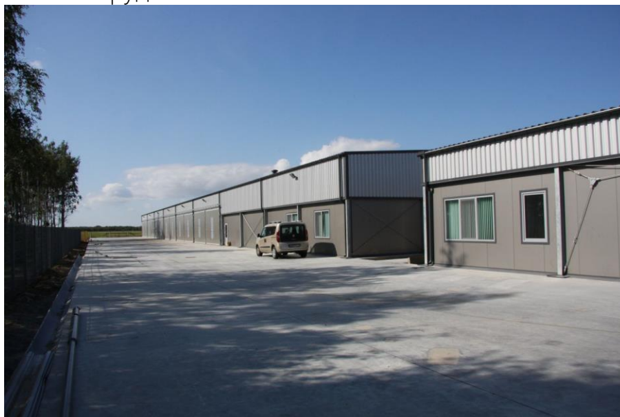
Рисунок 2.4. Пример здания шампиньонной фермы
